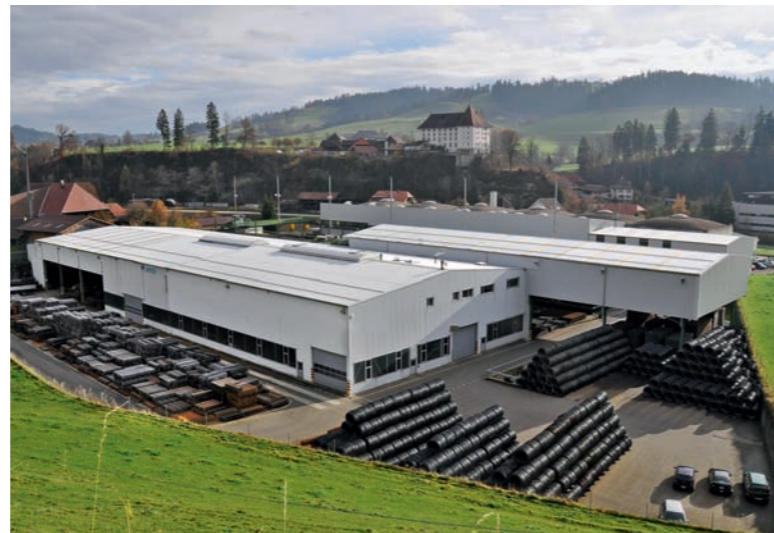
Die Werkhallen der Ruwa Drahtschweisswerk AG in Sumiswald. Fotos: Theler
