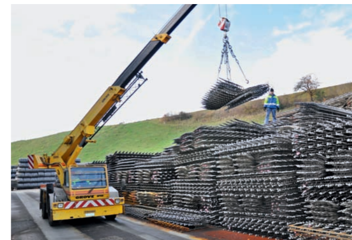
Eine Lieferung mit standardisierten Distanzkörben wird vorbereitet.
